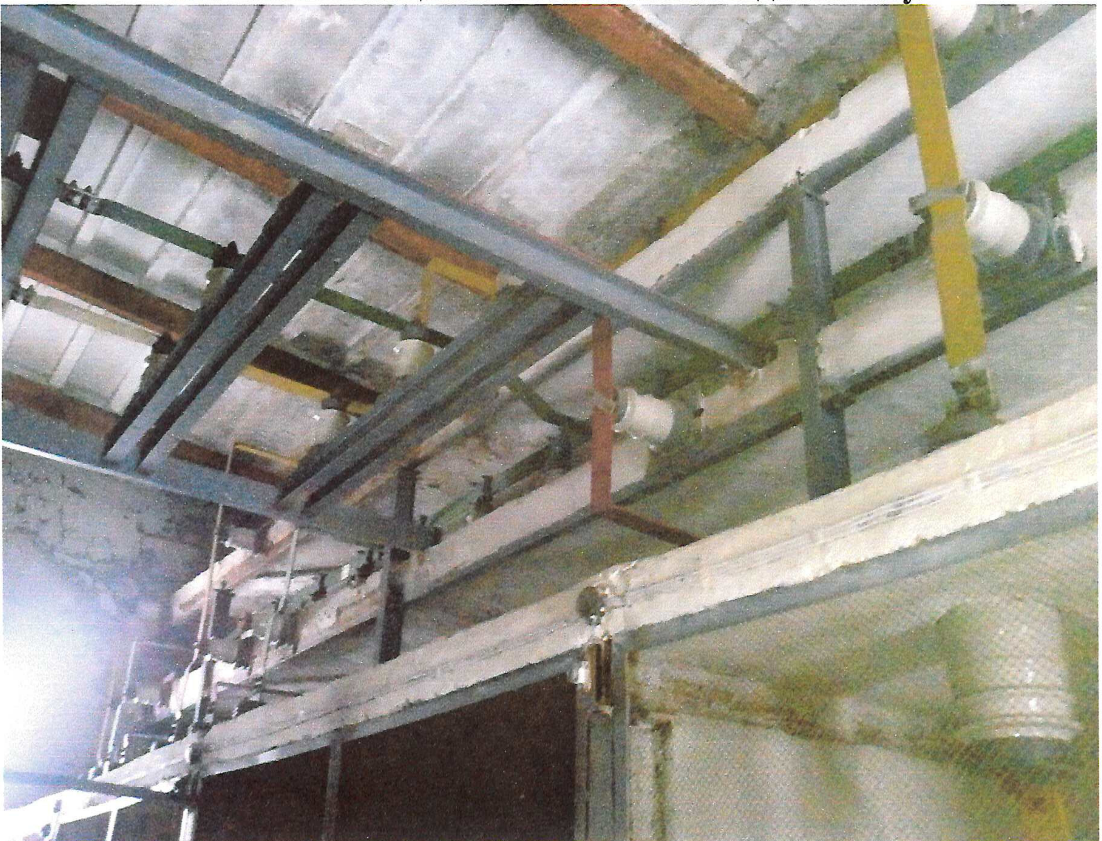
ЗРУ СН готовящаяся собственником к демонтажу.
